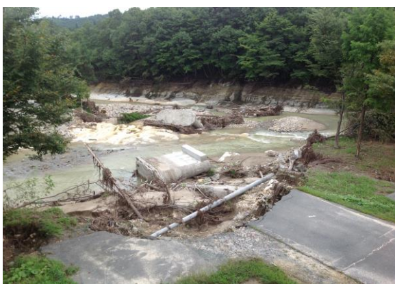
(紫波雫石線 矢櫃橋)
